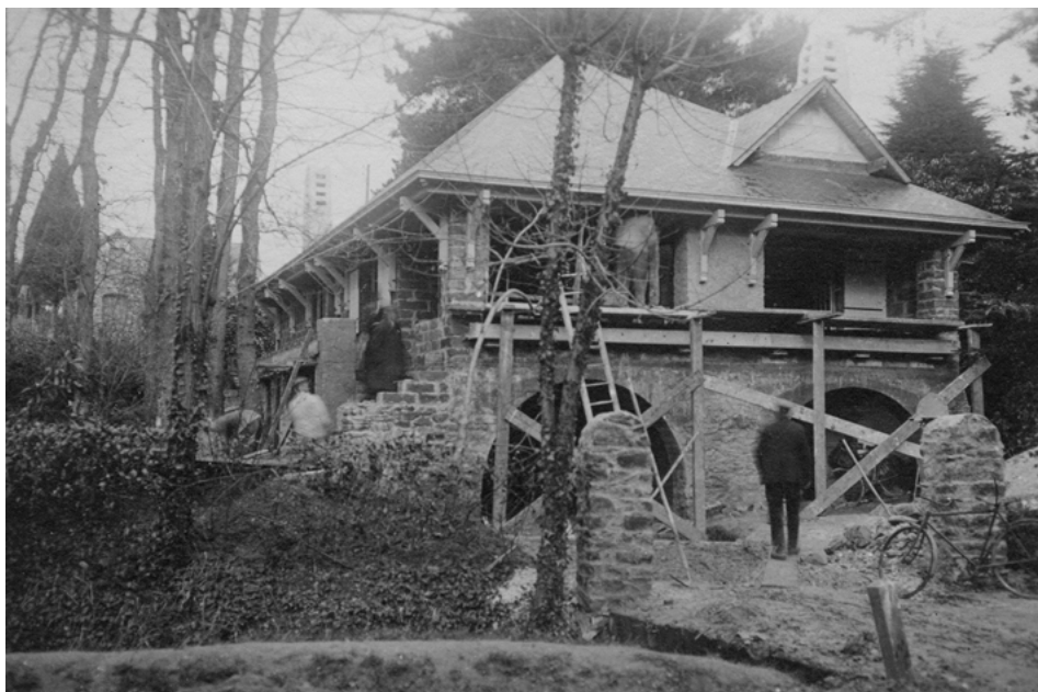
Le chantier d'agrandissement de la villa de Ker Bois , à Saint-Marc-sur-Mer, achetée par Henri et Lucienne en 1927.
